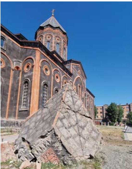
Žemės drebėjimo sugriautos cerkvės kupolas surinktas iš gabalų ir sumontuotas ant žemės.
